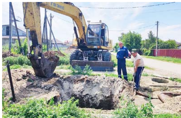
Бригада МУП «Юбилейный» на аварийно-восстановительных работах.
