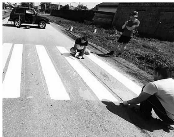
Черноречье. Обновление дорожной разметки.
