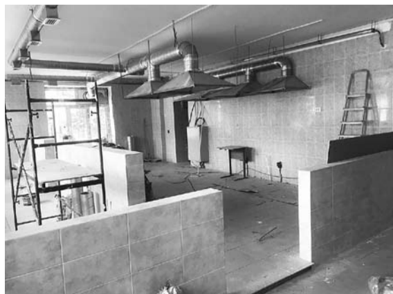
Ремонт кухни в школе Лопатино.
