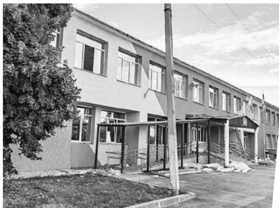
Ремонт фасада школы села Рождествено.
